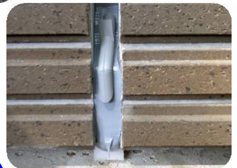
③水抜きパイプの設置
