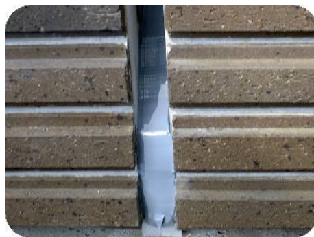
②下地シールの施工
