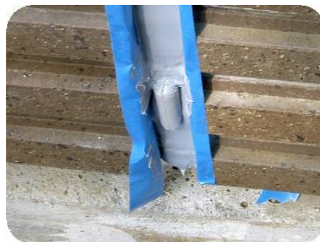
⑤目地のシーリング仕上げ
