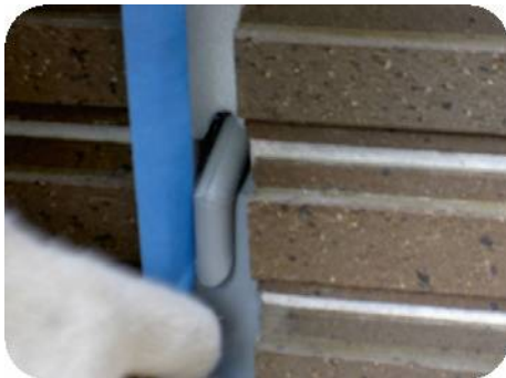
④上部にバックアップの設置
